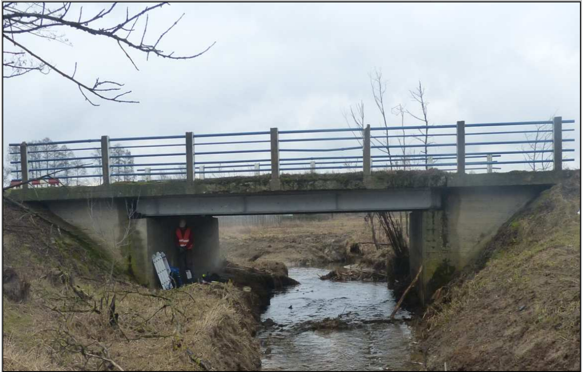
Rys. 2.2 Widok na obiekt od strony wody dolnej
