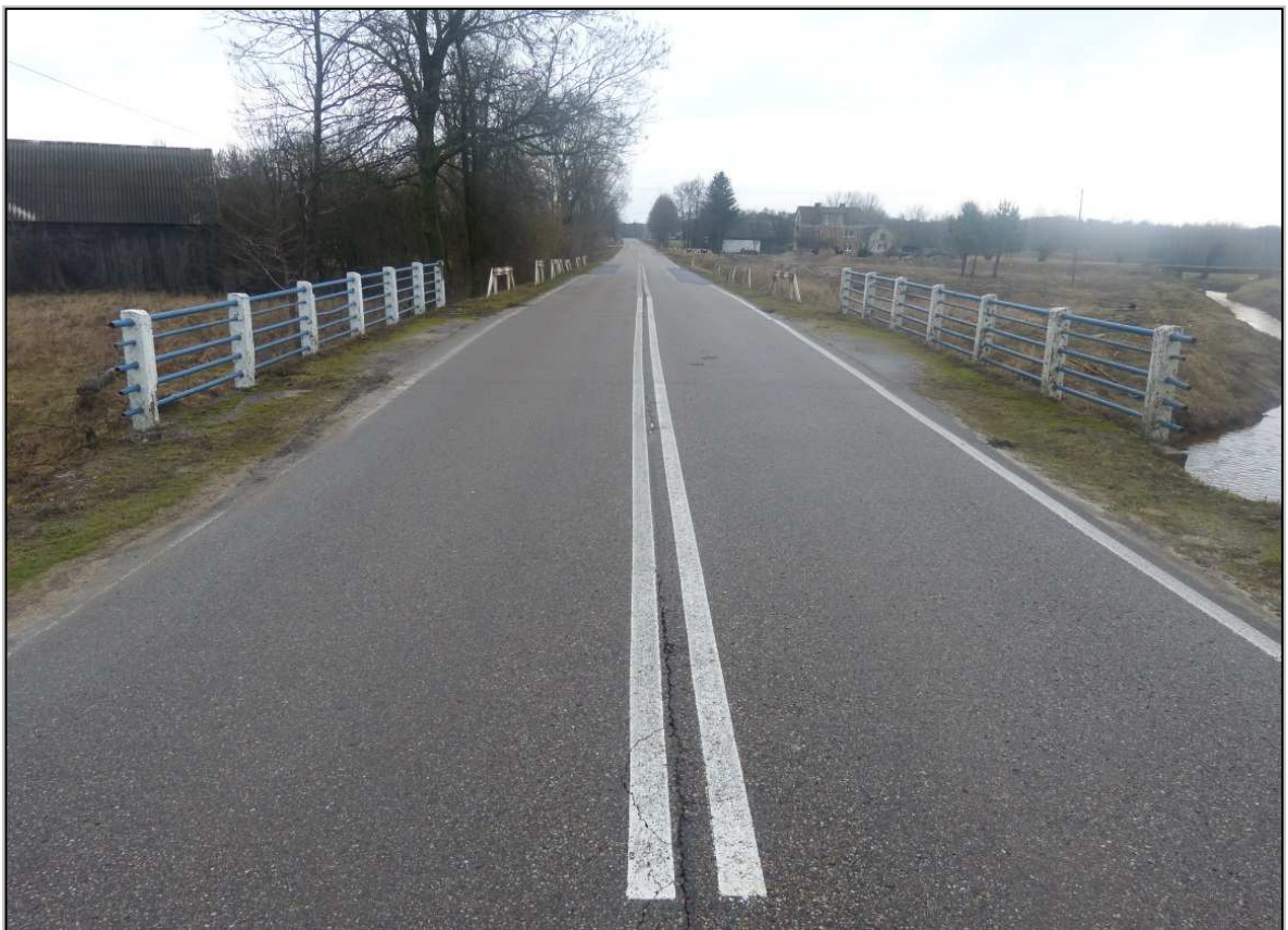
Rys. 2.3 Widok na obiekt od strony Miase
